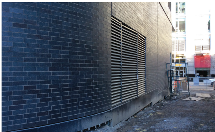
Le poste de mesure est installé sur un muret.
