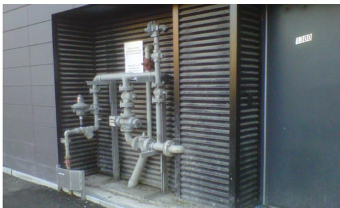
Le poste de mesurage est installé dans la cavité d'un mur du bâtiment, avec ou sans persienne.
