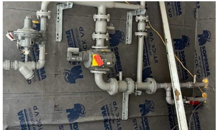
**Problème d'identification et d'accessibilité :** aucun robinet n'est clairement identifié avec les couleurs et les pictogrammes appropriés, et les robinets se trouvent à l'intérieur d'un bâtiment.
